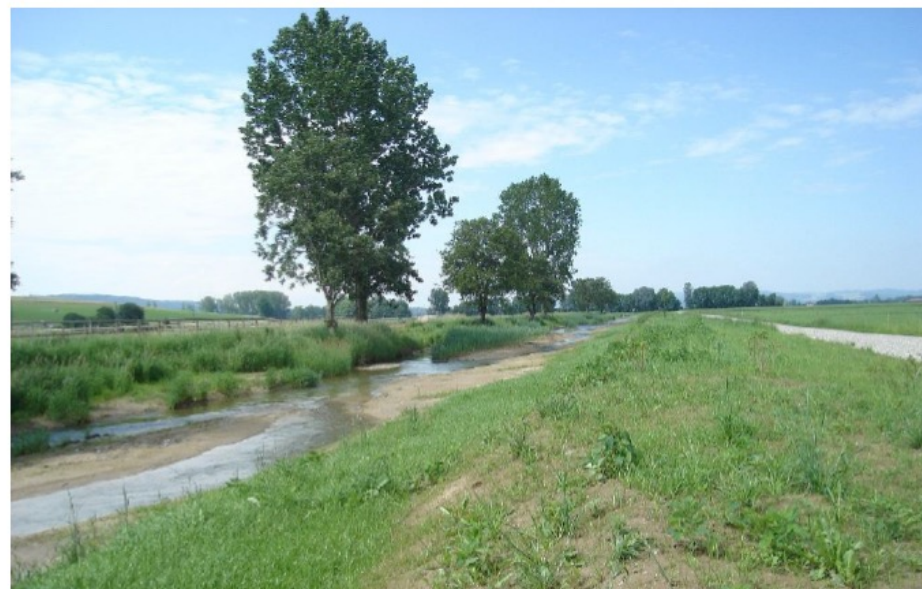
Situation juin 2008, réception des travaux
