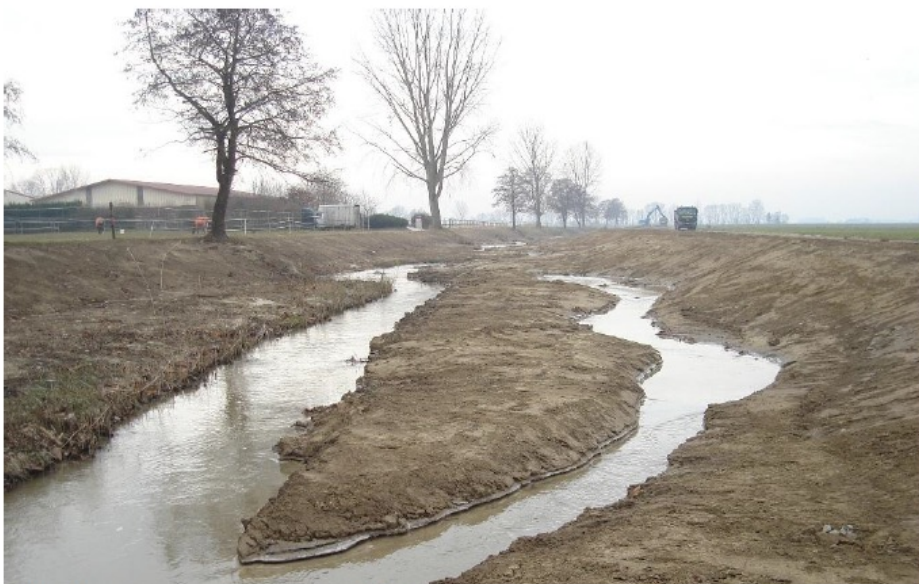
Etat des travaux novembre 2007
